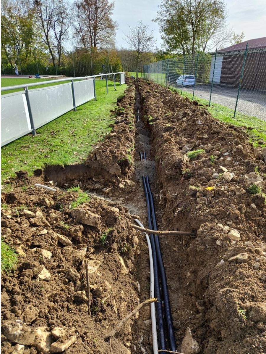
Nach dem Bau ist vor dem Bau! Unter diesem Motto verlegten wir mit vielen fleißigen Helfer\*innen Ende Oktober die Stromversorgung zur Bahn. Aufgrund der guten Organisation im Vorfeld, war die Arbeit in wenigen Stunden erledigt und die Rohre verschwanden im Boden.
